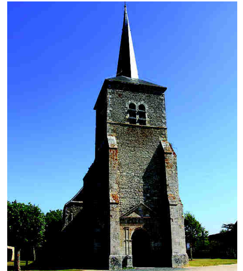
37 - Saint-Maurice sur Fessard : Église
