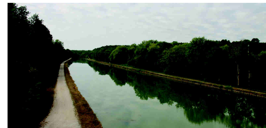
Canal du Loing à Bagneaux-sur-Loing (RD 40)
