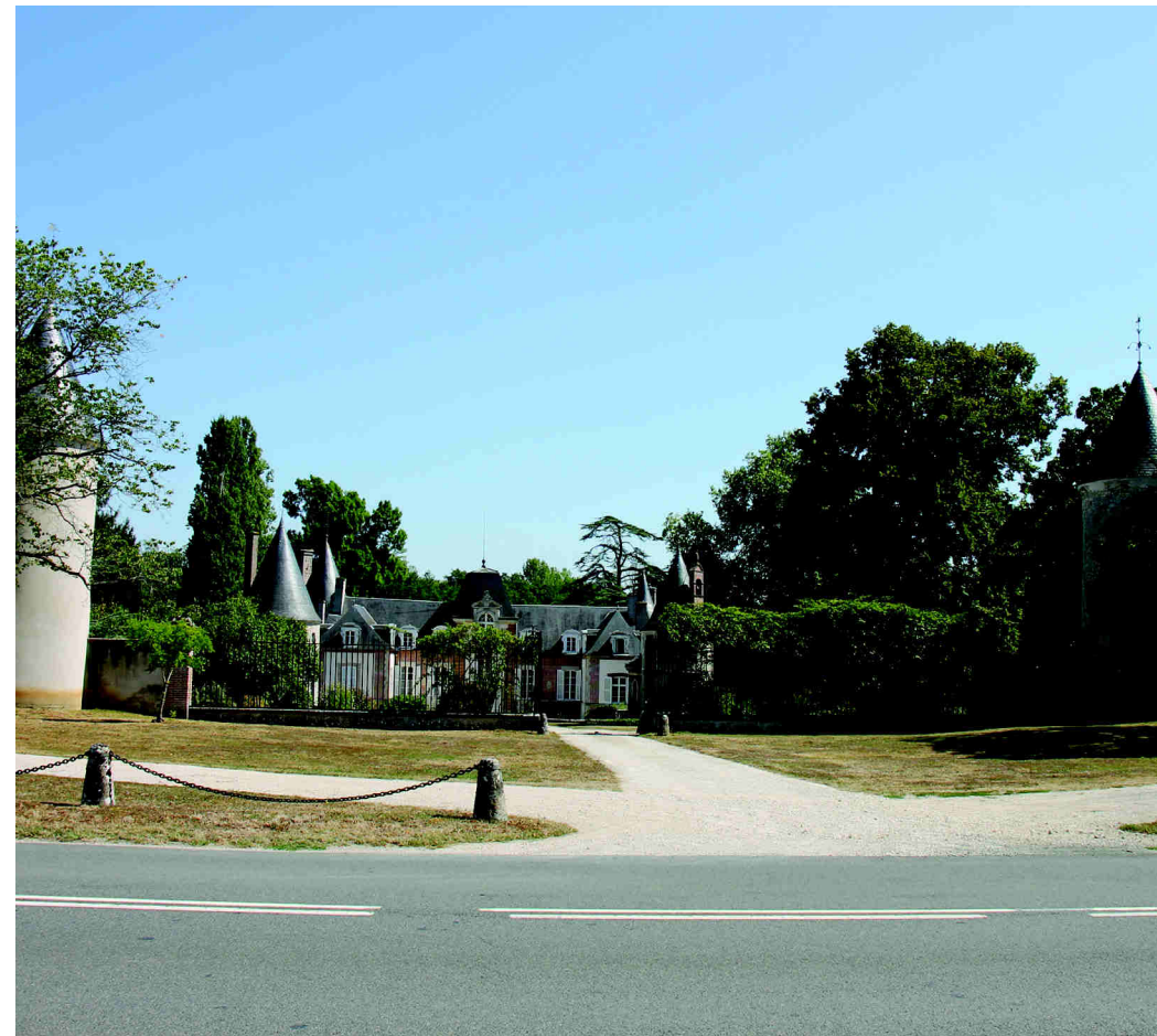
16 - Aulnay-la-Rivière : Château de Rocheplatte
